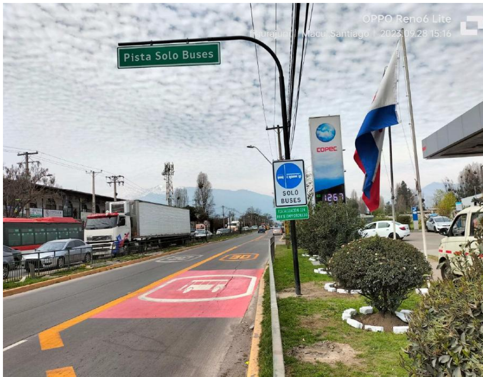
Figura N° 12: Ubicación de Poste Bandera, junto con señal informativa "Pista Solo Buses" y RO-11a montada. Imagen de Av. Gabriela, elaboración propia.
