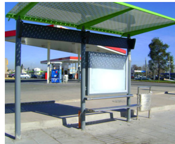
2. Refugio simple Estructura distinta a la demás tipologías, asiento curvo e incómodo. Fuente: Archivo DTPM
