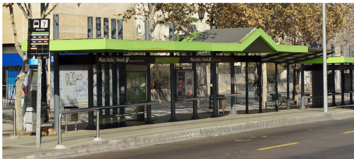
5. Refugio Tipo Estación de Transbordo Estructura sobredimensionada que obstaculiza la visibilidad desde la acera. Fuente: Archivo DTPM
