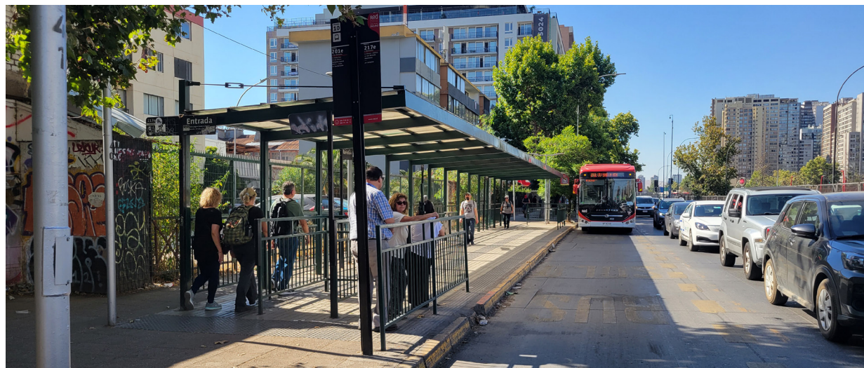
4. Estructura Provisional Zona Paga Estructura diseñada como elemento temporal y complementario sin estandarización de piezas o medidas. Fuente: Archivo DTPM
